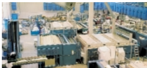
Een industriële wasserij
